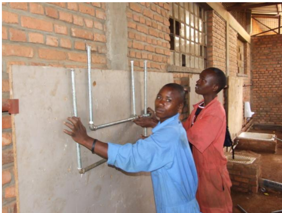
Im Bereich Klempnerei lernen die Jugendlichen unter anderem Rohre passgerecht zu zuschneiden und richtig zu installieren.
