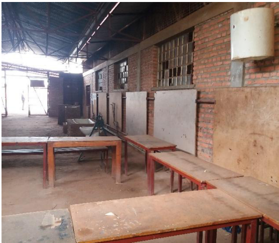
Die Halle vor dem Umbau:
