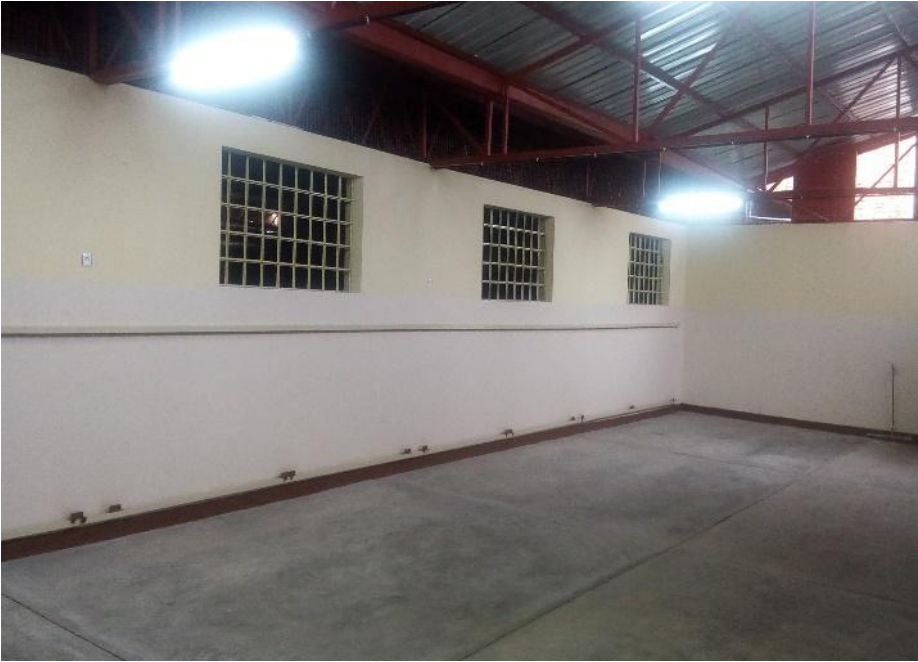
Die Halle nach dem Umbau:
