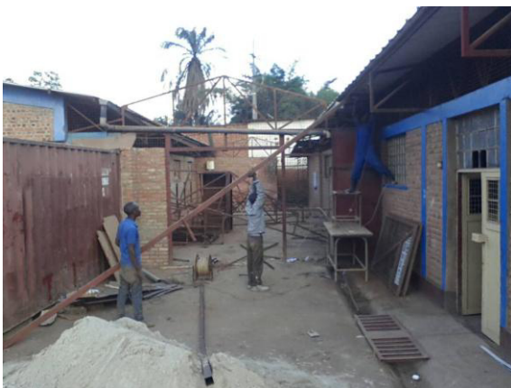
Die Halle beim Umbau:
